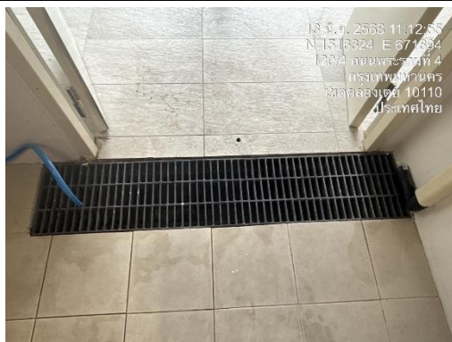
รูปที่ 18 รางระบายน้ำภายในห้องพัสดุรวม
