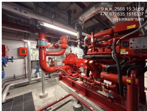
รูปที่ 7 น้ำสำรองดับเพลิง
