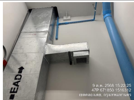
รูปที่ 19 พัดลมดูดระบายอากาศ
